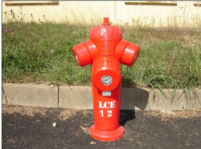
**Poteau incendie de 100 mm avec une sortie de 100 mm et deux sorties de 65 mm**
