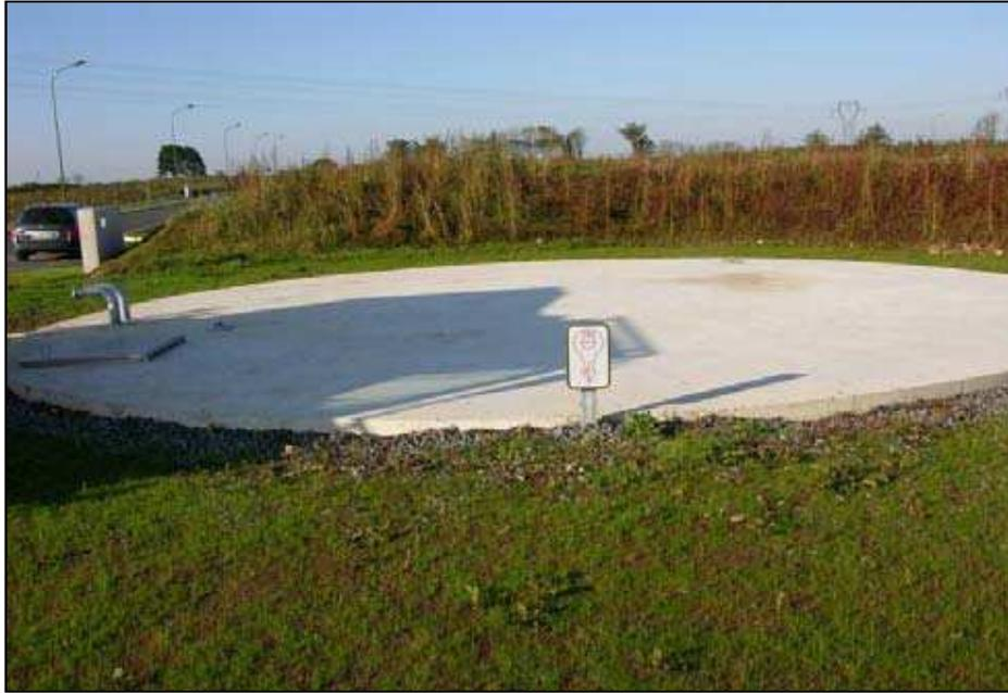
**Réserve d'eau enterrée avec 2 colonnes d'aspiration**
