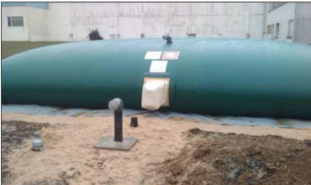
**Réserve d'eau souple de 120 m<sup>3</sup> utilisable par le biais d'une colonne d'aspiration de 100 mm**
