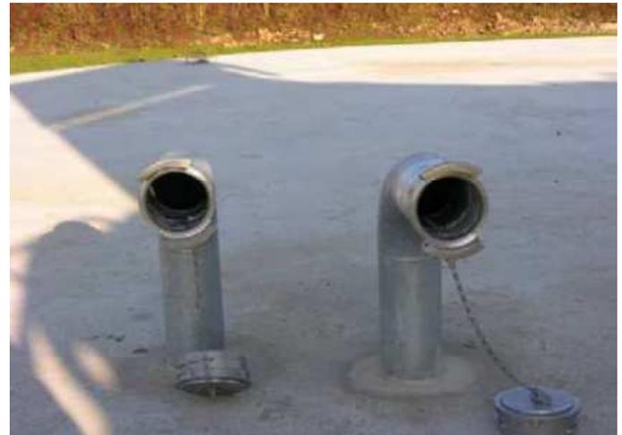
**Deux colonnes d'aspiration de 100 mm une réserve d'eau enterrée**
